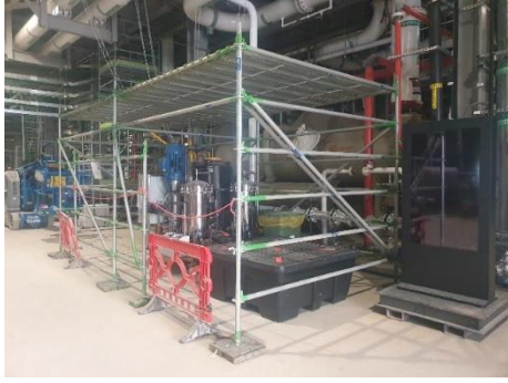
سقالة مبنية فوق المعدات المحيطة بها لحمايتها من التلف.
