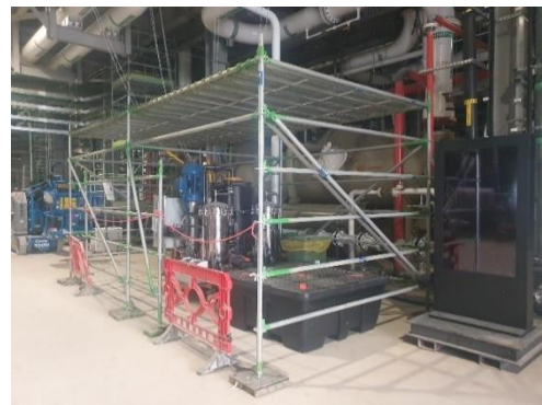
Строительные леса построены поверх и вокруг оборудования, чтобы защитить его
